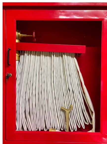
Modelo 410 Hidrante completo: manguera válvula, chiflon, llave, gabinete y soporte
